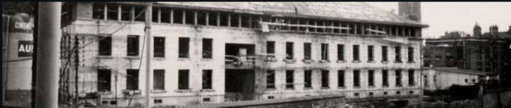
Construction du rectorat, 1 rue Navier à Reims (1964)
