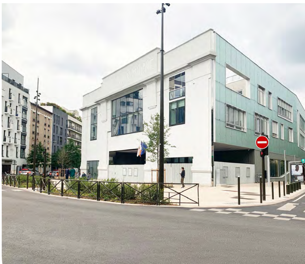
Lycée du Trapèze, Boulogne-Billancourt (92).
