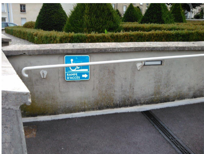
Rampe d'accès PMR
