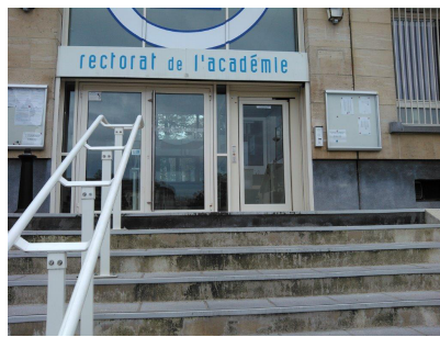
Escalier principal extérieur
