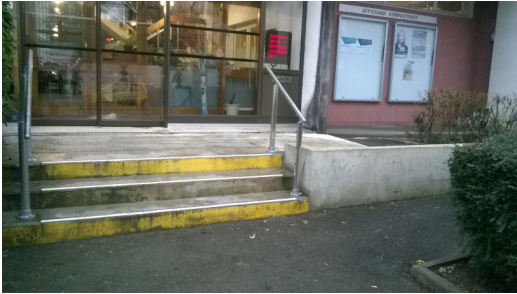
Escalier principal extérieur
