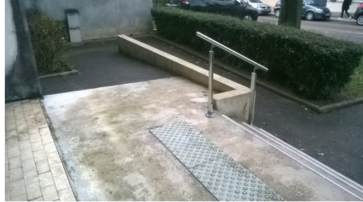
Rampe d'accès PMR
